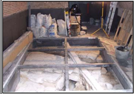
Vista general dels testimonis arqueològics posats al descobert en el transcurs de l'obra
